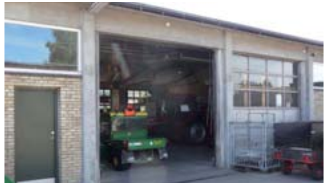
Garagebygning vest for bevaringsværdig bebyggelse, bygning 94, nedrives.
