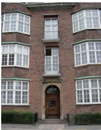
Facadeudsnit fra ejendommen på hjørnet af Strandvejen og Strandvænget. Øverst anes den markante gesims mellem 3. og 4. etage.
